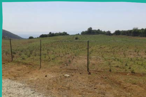
(β) Πρώτη φάση αποκατάστασης
